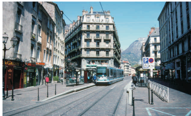
Grenoble: Niederflurstationen sind städtebaulich vollständig integriert und fallen kaum auf
