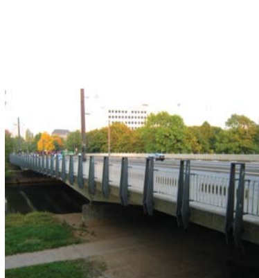
Die Leinertbrücke zwischen Linden und Hannover
